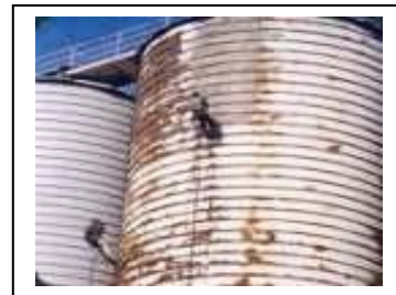
Слика 72. Растакање силоса
