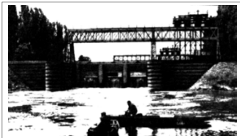
Слика 67. Електрифицирана бродска преводница на Тиси код Новог Бечеја (пројектовао француски конструктор Ајфел)
