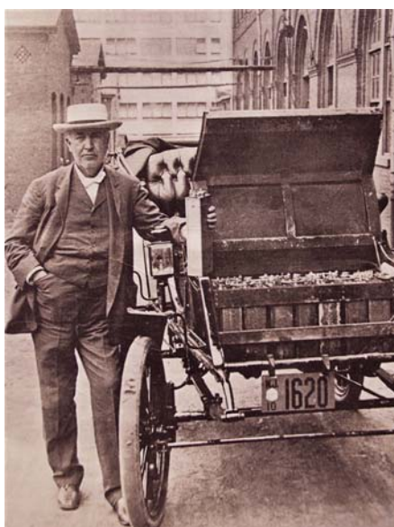
Sleva: Tomas Edison, u saradnji sa Henrijem Fordom, konstruisao je elektromobil, pored koga pokazuje i svoje baterije. Desno: Edison i Ford (Detroit, 1929).
