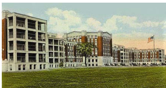
Tercijalna bolnica, koju je izgradio Henri Ford u Detroitu (slika iz 1919)
